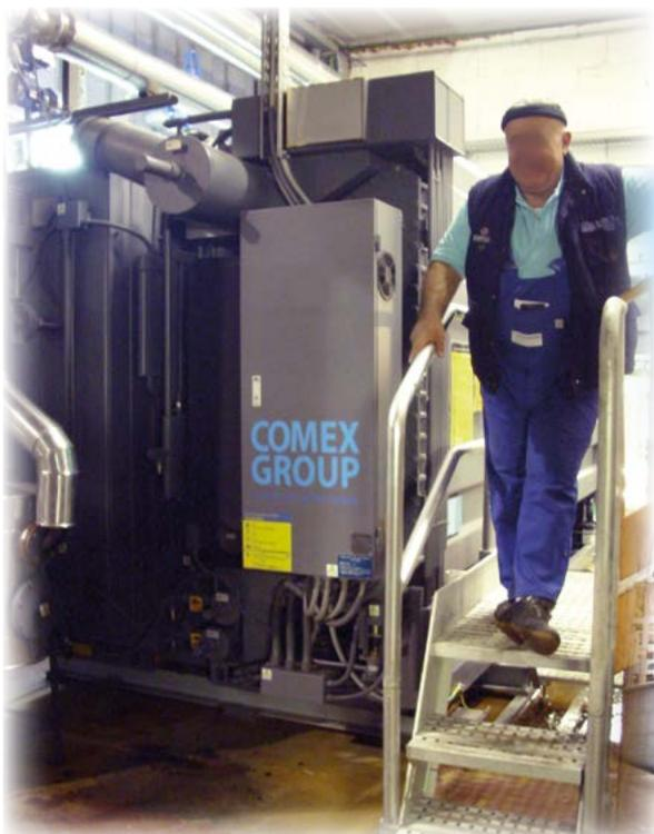
Die Installation des Genius in SKID-Kraftwerk bei einer Papierindustrie in Catania wird von der **TURBOGAS**-Anlage gespeist, die **1 MW Kälte** in Trigeneration erzeugt.
